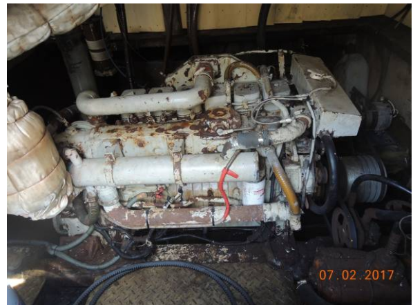
編號 1、金龍興 3 號 柴油機現況
