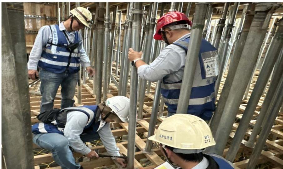
鋼管支撐排架由工地職安人員一同現場查驗，以落實工地安全。
