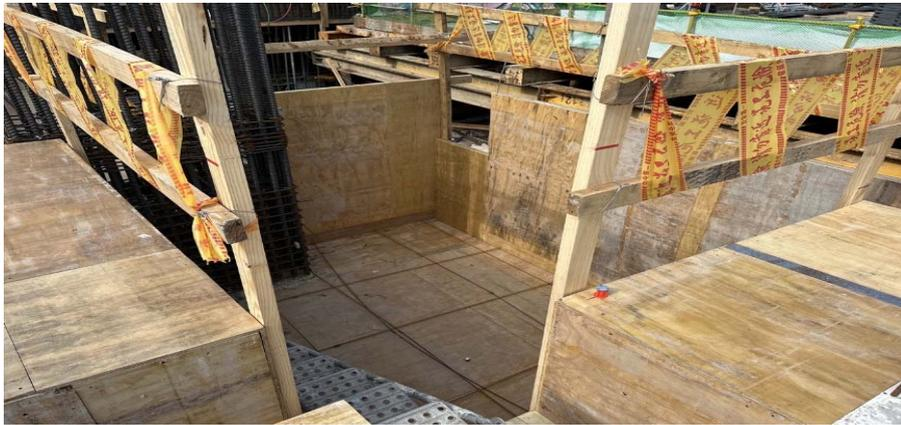
版面施工期間開口處設置臨時護欄避免人員墜落。
