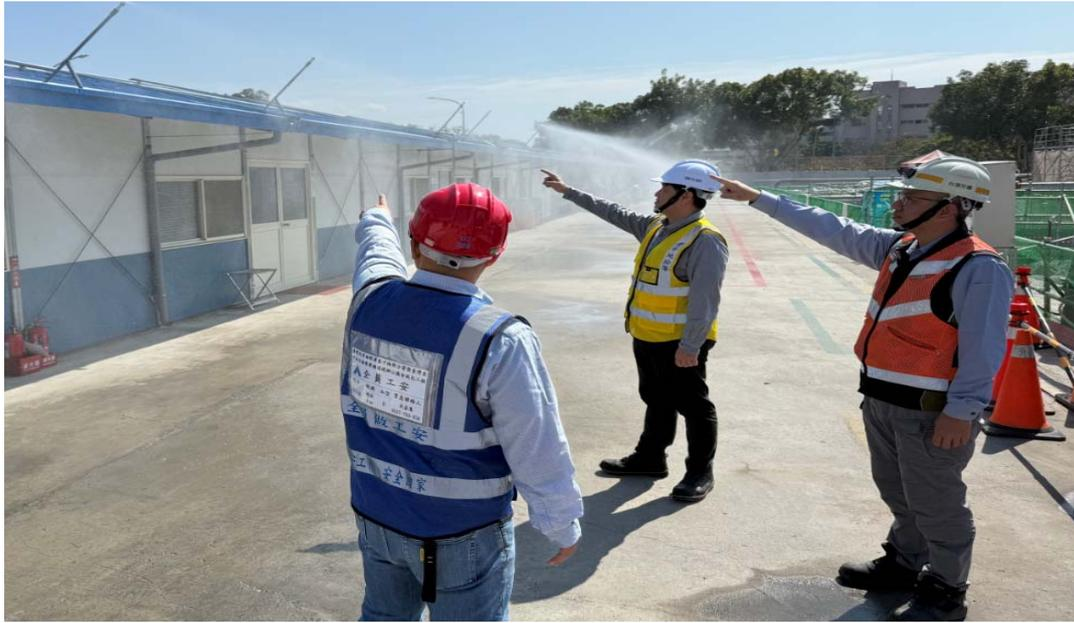
本工地設置雲端智能灑水系統(pm2.5 及 pm10 超過數值即自動啟動)。
