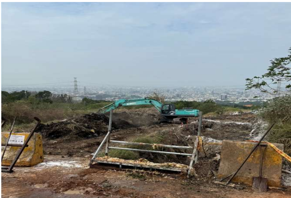
說明：沙鹿、大雅聯合區域性垃圾掩埋場廚餘掩埋作業現況。
