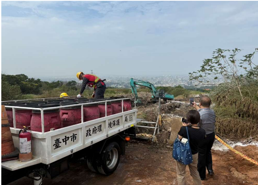
說明：洪國朝主任檢察官率同康存孝檢察官(右一)前往沙鹿、大雅聯合區域性垃圾掩埋場履勘，瞭解廚餘掩埋作業辦理情形。
