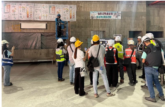
現場示範高處作業及防墜安全措施，結合職安宣導看板強化工地危害辨識
