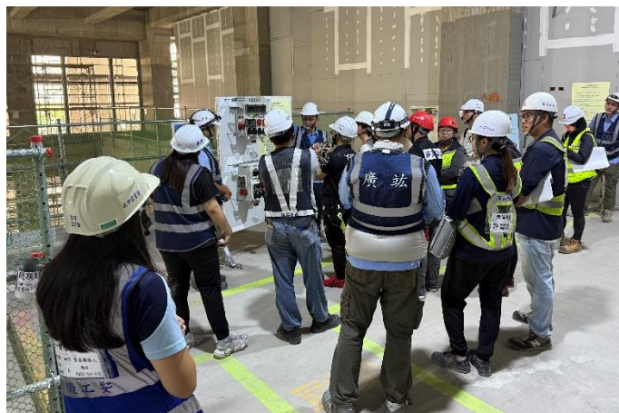
示範智慧電箱功能，掌握即時監測、漏電保護及自動斷電等科技防護機制
