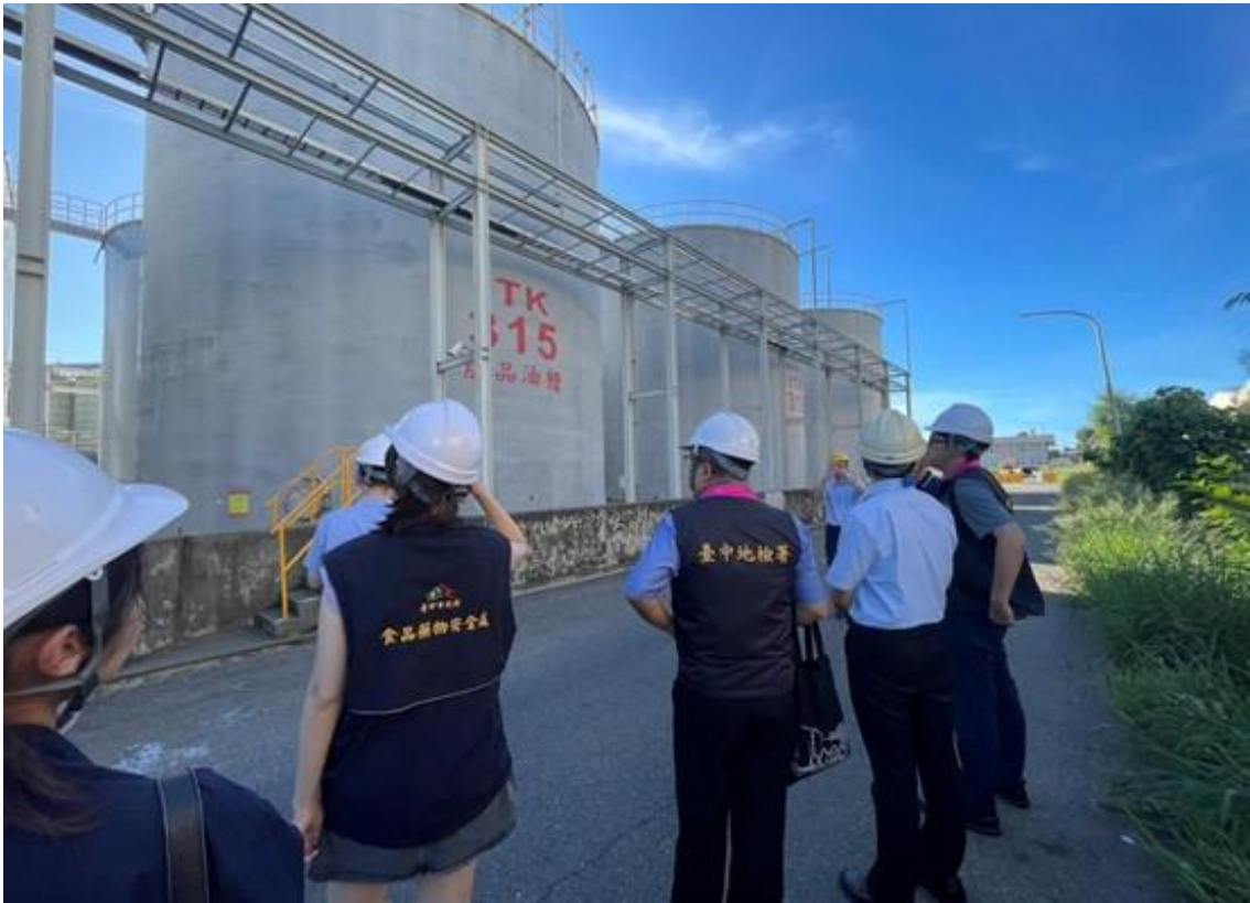
本署率員實地履勘中聯公司系爭 TK315 油槽
